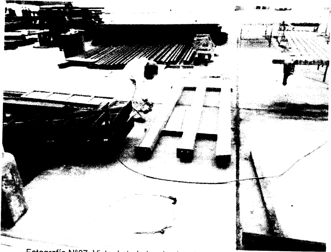
Fotografía N°07: Vista de trabajos de pintado de estructuras metálicas.
