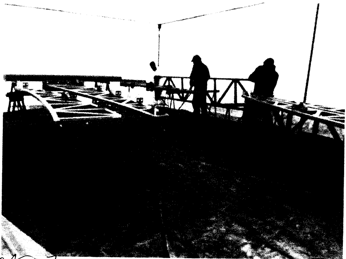
Fotografía N°04: Vista de caseta de pintura y realización de trabajos.
